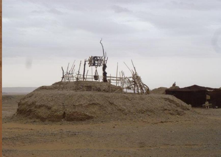
Staubtrocken sieht es aus in dieser Wüste, aber der Anblick täuscht. Die Aushubkegel verraten die Wasserkanäle zur Frischwasserförderung, die das Wasser vom hohen Atlas auch in weiter entfernte Regionen transportieren. Der Schöpfeimer hängt zur Bedienung bereit, so dass auch die Beduinen sich in ihrem einsamen Zelt mit dem lebensnotwendigen Wasser versorgen können.
